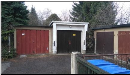
Abb. 3: Vor der Maßnahme: am rechten Bildrand durch Doppelgarage versperrter möglicher Zugang, 03.08.2017
