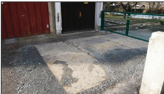
Abb. 5: Kurz vor Fertigstellung Maßnahme: Zugang mit Tor, 06.02.2018
