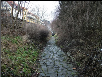
Abb. 2: Weidigtbach Überlauf, Blick stromab auf Einlauf in Verrohrung Weidigtbach Überlauf, 03.02.2014
