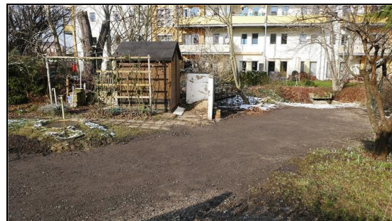
Abb. 6: Kurz vor Fertigstellung Maßnahme: Befestigte Zufahrt aus Schotterrasen, 06.02.2018
